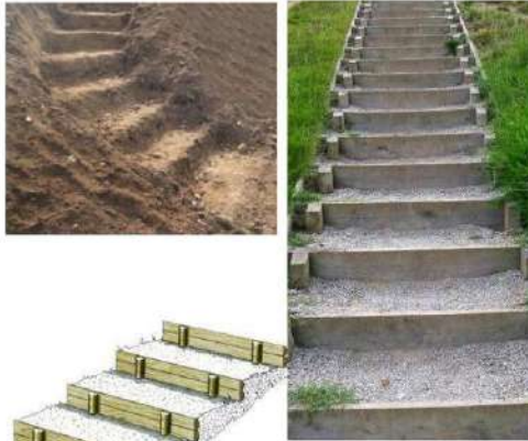
materiali: traversine (tipo ferrovia) legno impregnato n.15 H cm 30 luoghezza cm 80
